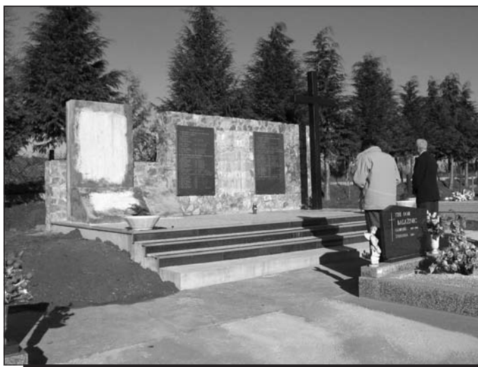
Na groblju u Donjim Mostima pred završetkom je izgradnja spomenika žrtvama ratnog i poratnog razdoblja Drugog
