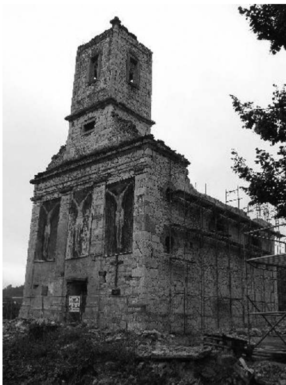
Boričevac, crkva u obnovi
